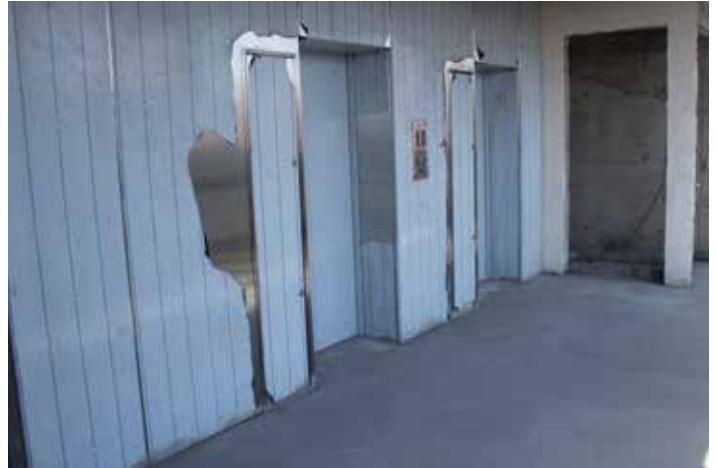
Asansör Holü Dolgusu Lapishan İş Merkezi | Kartal, İstanbul | Gürallar Yapı
