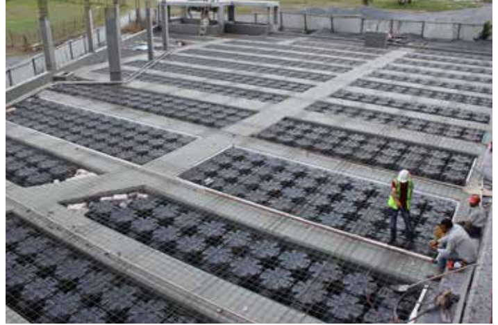
Ters Kiriş Dolgusu İÇTAŞ Yönetim Binası | Yenibosna, İstanbul | Derya İnşaat
